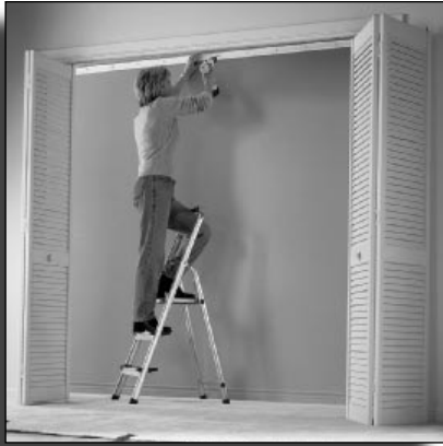
Skruva fast bärlisten i väggen nära taket eller i höjd med dörrfodret.
